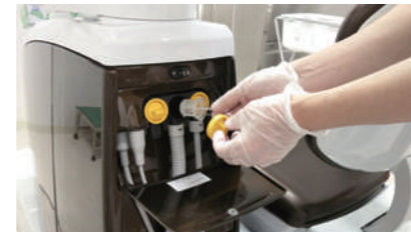
吸引管のフィルター交換
